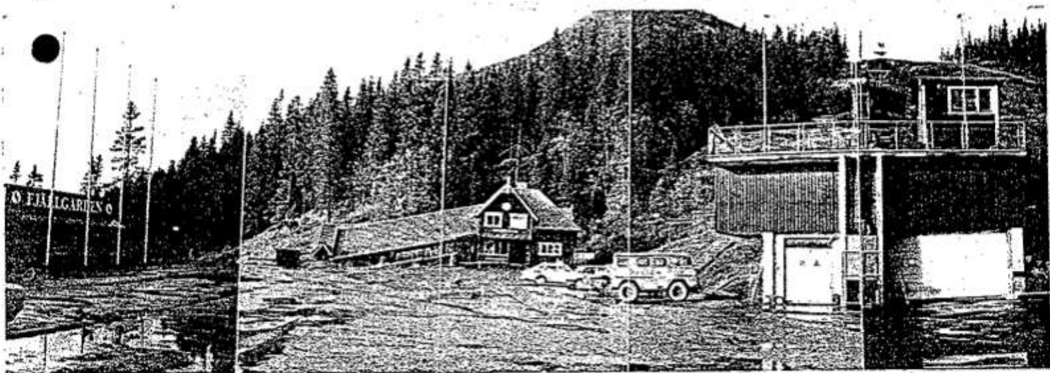
Bild 3. Fjällgårdsplåten från öster med Fjällgården till vänster, Bergbanestationen mitt i bild och Fjällgårdsliftens dalstation med nedfarten bakom sig och verkstadsutrymmen under.
